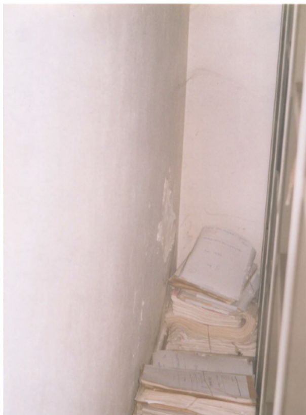
Rysunek 14. Zawilgocenie tynku w pomieszczeniu archiwum - ściana północno – zachodnia [3]
