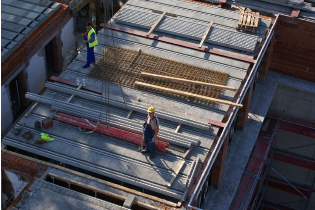
Rysunek 21. Nowo wykonywany strop w trakcie realizacji [2]
