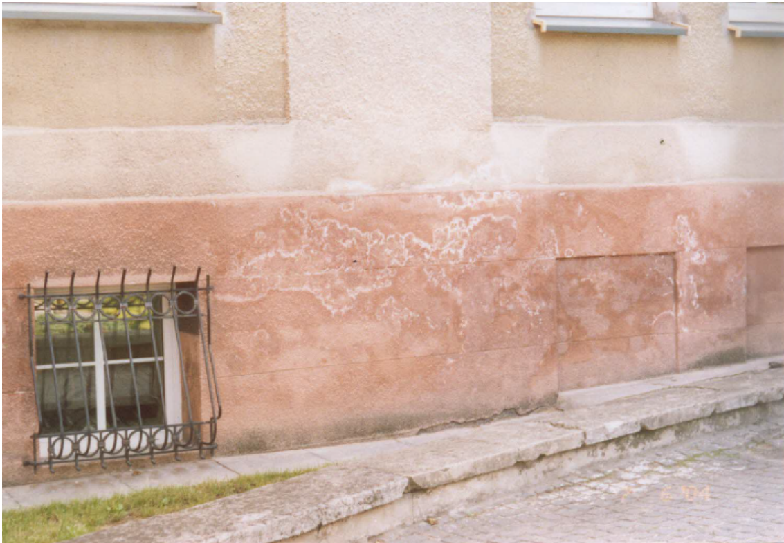
Rysunek 8. Wykwity solne na ścianie elewacji południowo-zachodniej [3]
