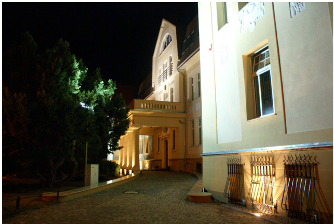
Rysunek 33. Elewacja frontowa w nocy – centralnie główne wejście do budynku [2]
