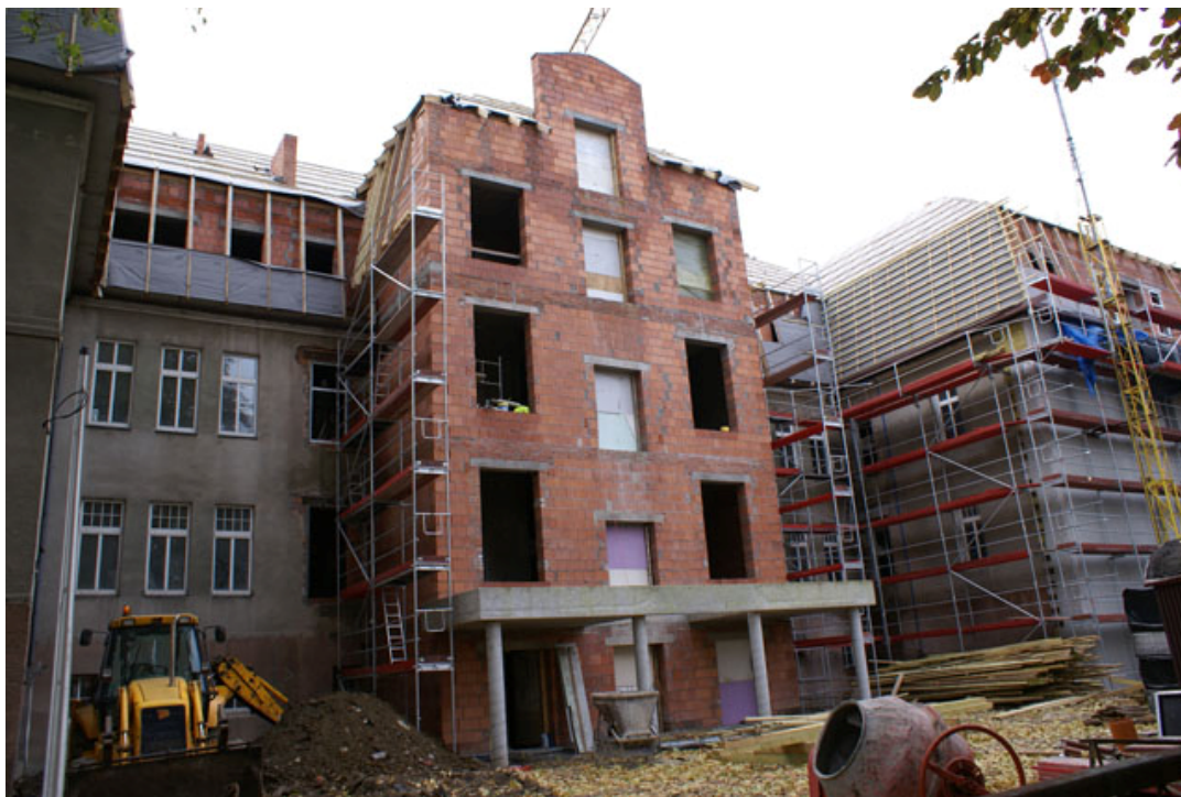
Rysunek 24. Nowo wykonywane wejście (tył budynku) [2]
