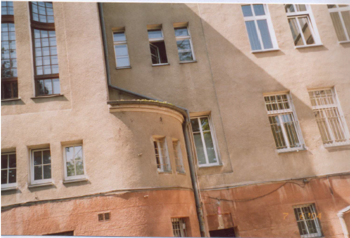
Rysunek 12. Zawilgocenie ściany północno – wschodniej na wysokości parteru [3]
