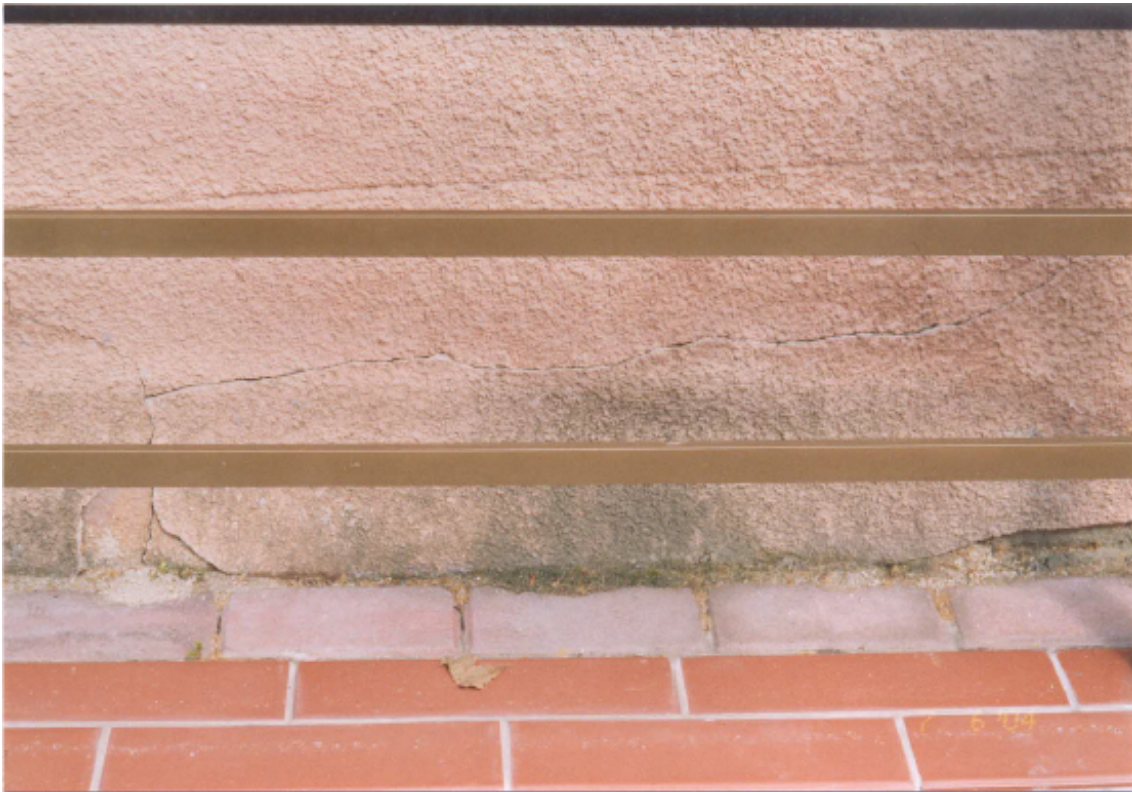
Rysunek 10. Zawilgocenie ściany na styku z terenem, przy wejściu od strony północno – wschodnia. Widoczne rysy i ubytki tynku do wysokości 30 cm [3]
