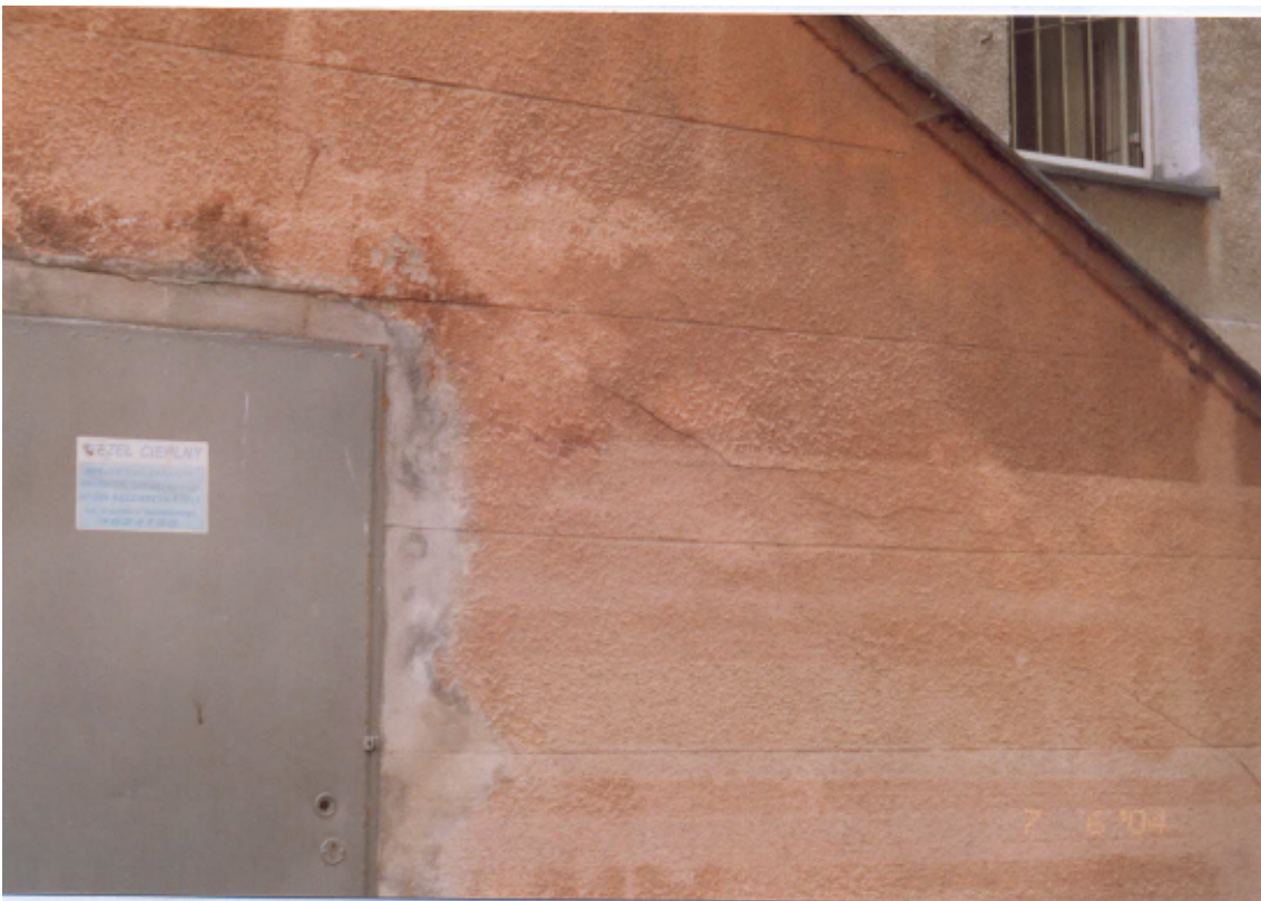
Rysunek 11. Zawilgocenie i spękania ściany przy wejściu do węzła ciepłego - elewacja północno – zachodnia [3]
