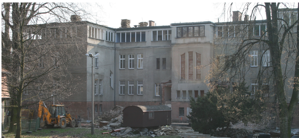
Rysunek 6. Dawny wygląd budynku urzędu miasta – tylna elewacja, rok 2010. Uwagę zwraca ostatnia kondygnacja, dobudowana w latach 1972-1973 [4]
