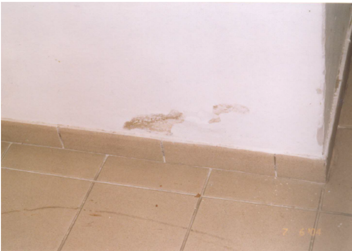
Rysunek 17. Zniszczenia tynku w korytarzu piwnicy [3]
