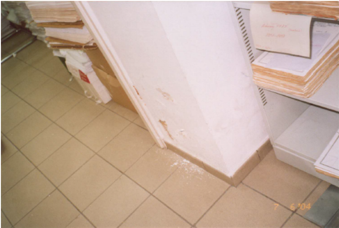
Rysunek 16. Zniszczenia tynku w pomieszczeniu archiwum (ściana wewnętrzna) [3]
