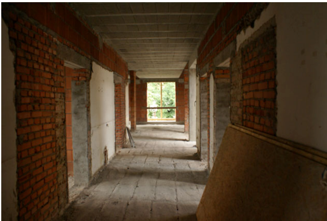
Rysunek 20. Wewnętrzne ścianki działowe, widoczne przebicia wypełnione cegłą pełną [2]
