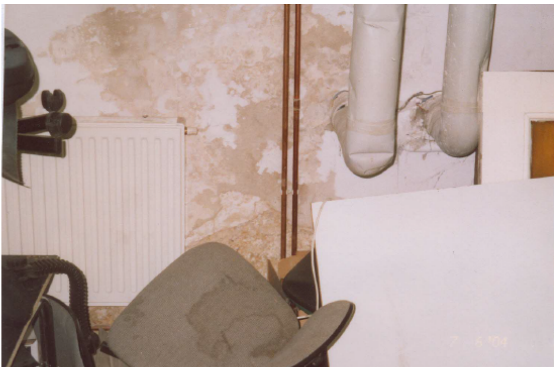
Rysunek 13. Zniszczenia tynku w pomieszczeniu zaplecza pracowni kserograficznej (ściana południowo-zachodnia) [3]
