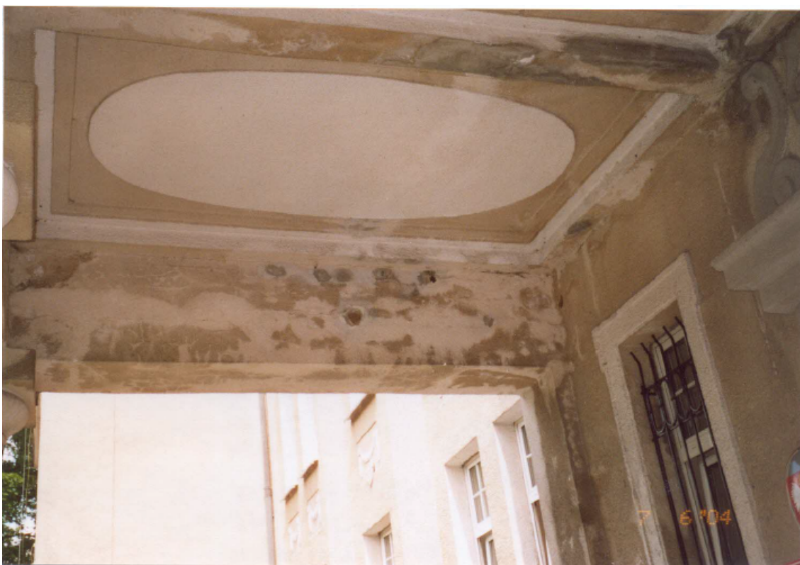
Rysunek 7. Zawilgocenie elementów zadaszenia (płyty balkonowej) nad wejściem głównym do budynku [3]
