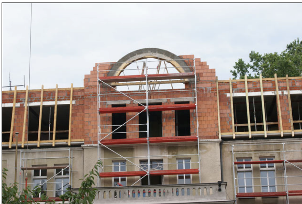
Rysunek 19. Nowo wznoszona kondygnacja – widok od strony frontu [2]
