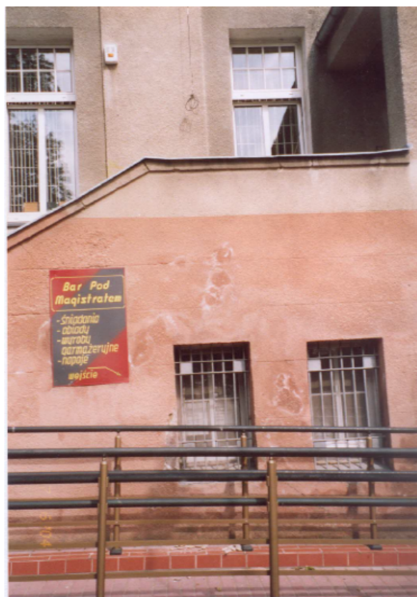
Rysunek 15. Wykwity solne przy wejściu od strony południowo-wschodniej [3]
