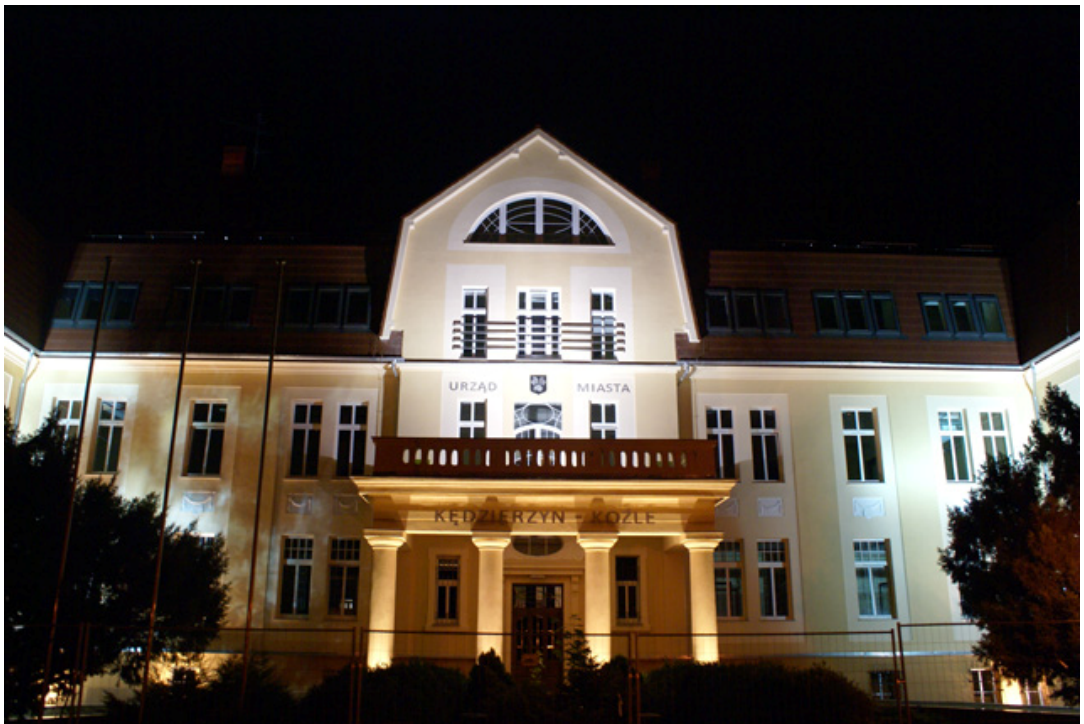
Rysunek 31. Elewacja frontowa nocą – nieco bliżej [2]
