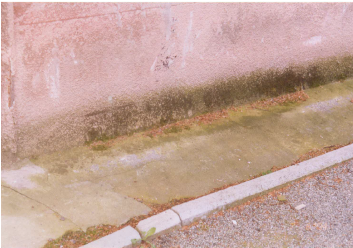
Rysunek 9. Zawilgocenie ściany na styku z terenem – elewacja północno – wschodnia [3]
