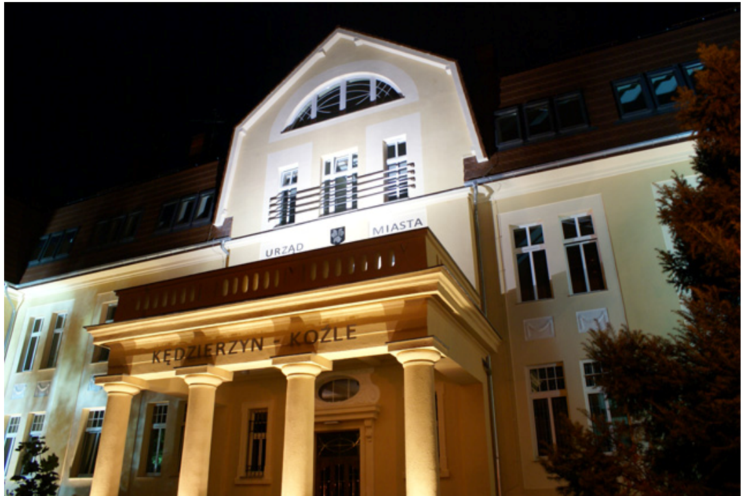
Rysunek 32. Elewacja frontowa nocą - zbliżenie na balkon [2]
