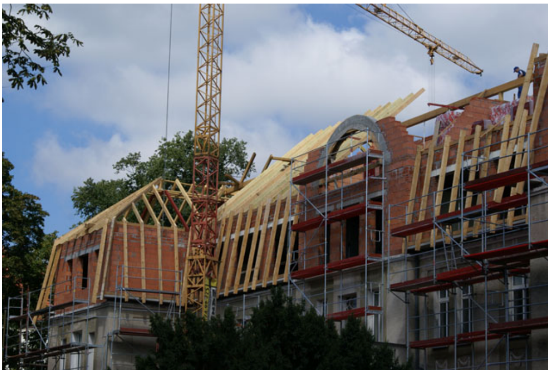
Rysunek 22. Wieżba nowo wykonywanego dachu [2]
