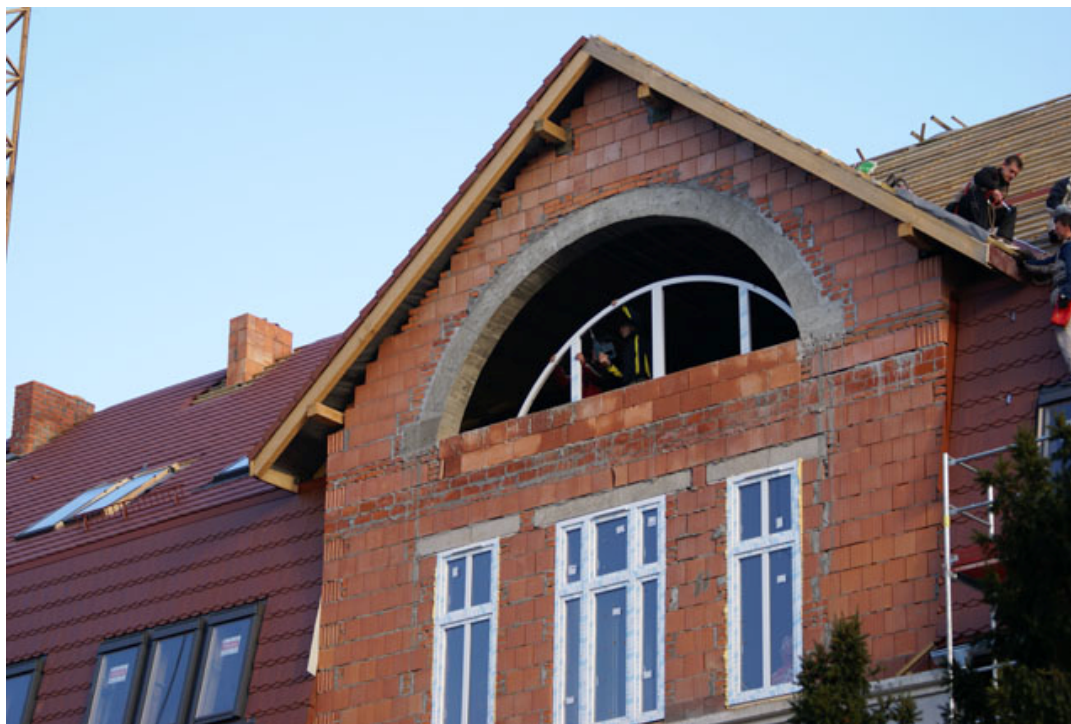
Rysunek 28. Ostatnie podrygi przy wstawianiu stolarki okiennej – kolej na lukarnę [2]
