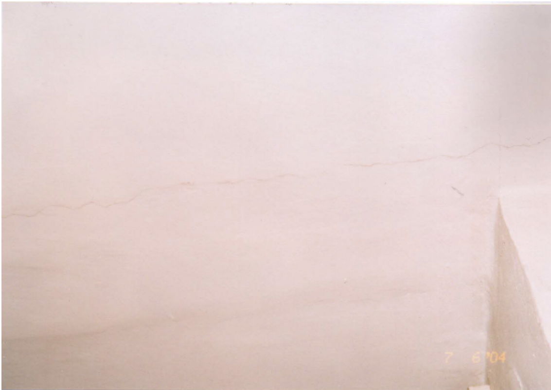
Rysunek 18. Zarysowania płyty nośnej stropodachu [3]
